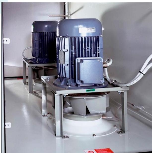
Рис. 3. Резервирование вентиляторов
